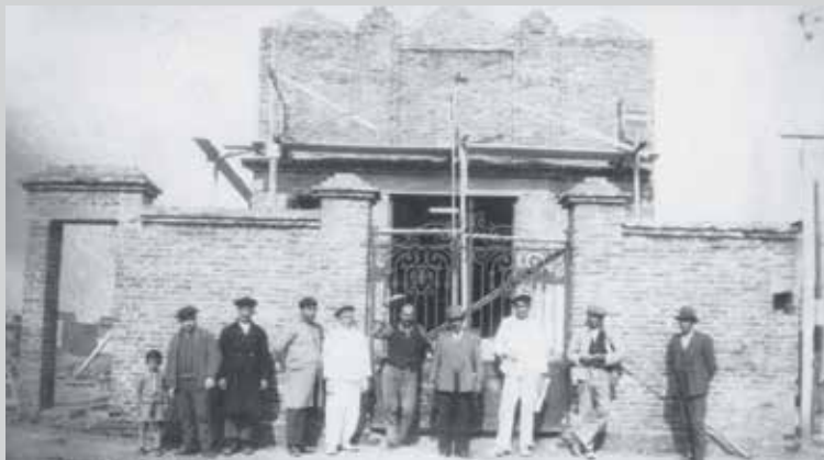
Construcción de la Escuela armenia Jrimian. Valentín Alsina, Buenos Aires. 1936
